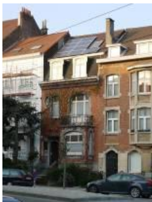
u- Bruxelles : capteurs solaires en toiture sur maison de ville © Bernard LENSEL
