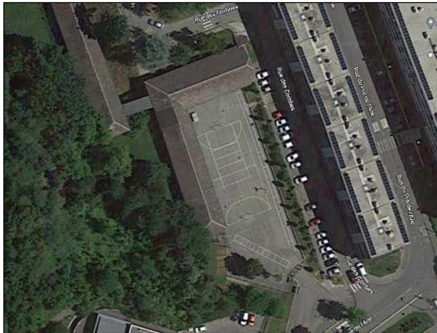
Situation avant travaux
