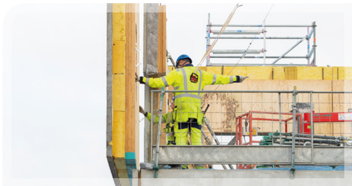
ARKTA RAKENNUS ET METSÄ WOOD / ELMERIELO / MAGAZINE HORS SITE
