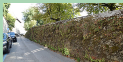
Mur de la rampe de la Treille à Genève I © Sandrine Larramendy, Plante & Cité
